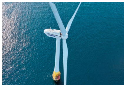
国内初の商用浮体式洋上風力発電施設
