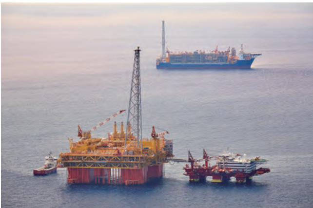
現地に到着したCPFとFPSO
