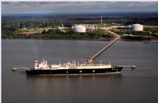
タングーLNG払出栈橋
