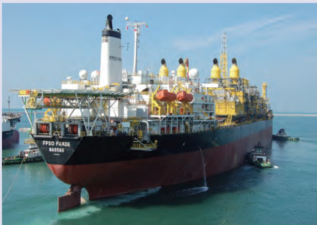
フラージ油田のFPSO
