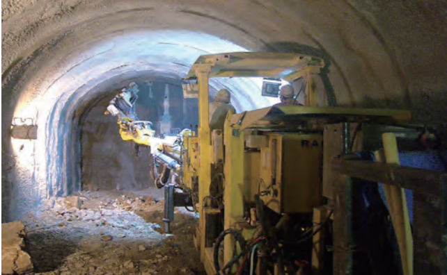
山岳トンネルの掘削 硬い岩盤や出水に阻まれながら山岳トンネル5本(総延長約12.6km)が掘削された
