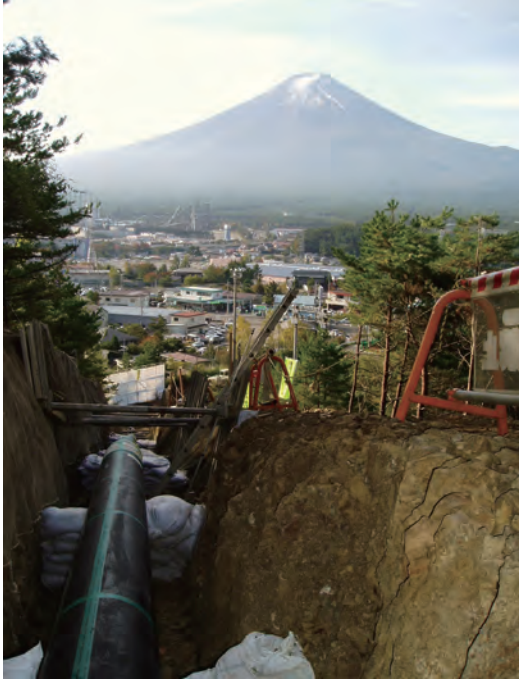
静岡ライン建設工事
