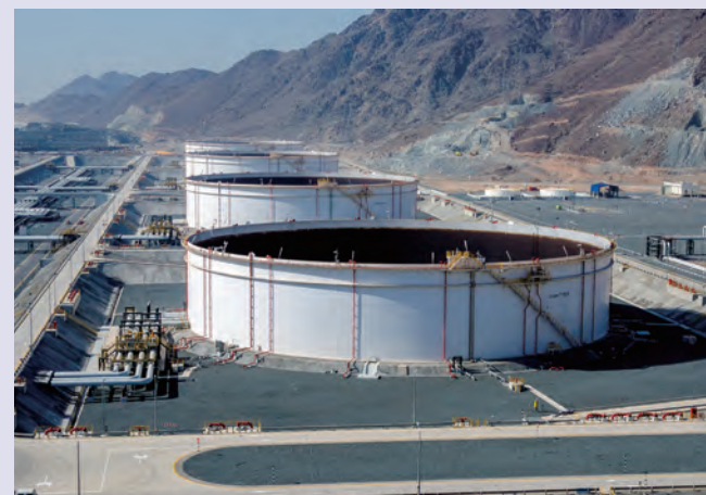
ADCO鉱区の生産原油（マーバン原油）の出荷を行うフジヤラターミナル
