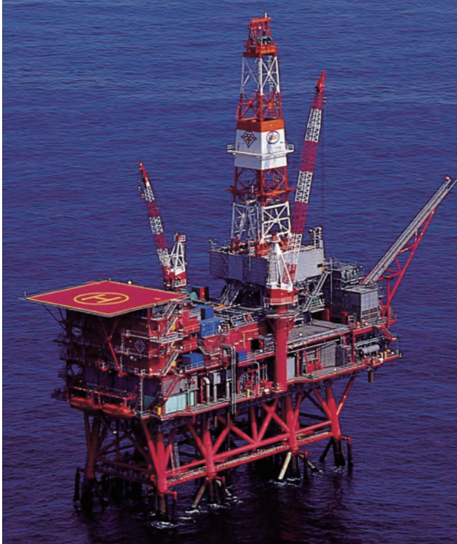
磐城沖ガス田 福島県双葉郡楢葉町沖合40km(水深154m)に建設した海洋プラットフォーム
