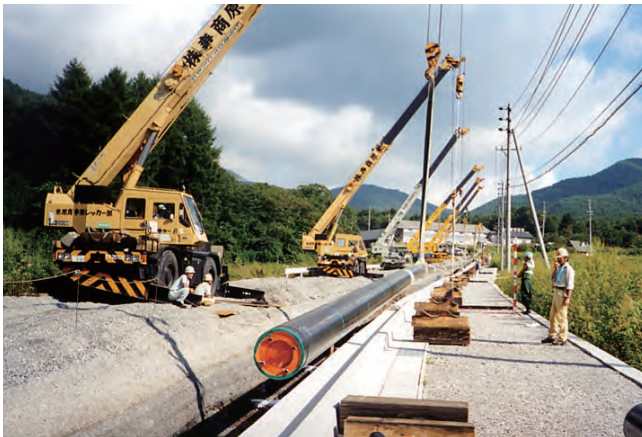
松本ライン建設工事
