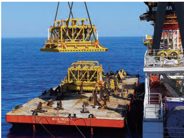
海底坑口装置(Manifold)の設置作業
