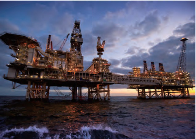
カスピ海ACG鉱区の生産施設
