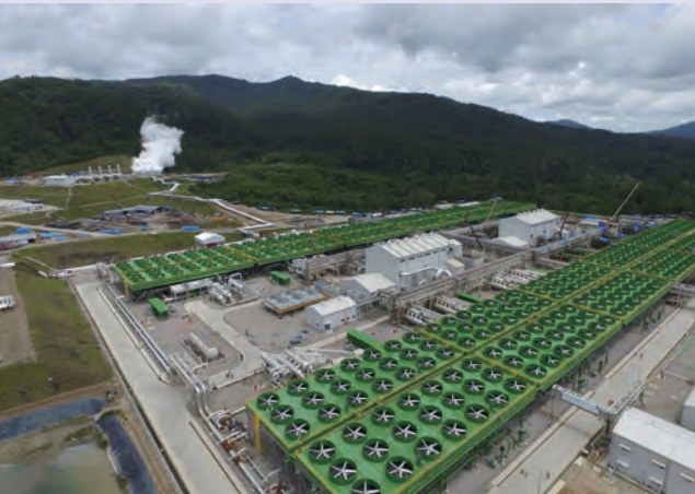
稼働を開始したサルーラ地熱発電所 (2017年)
