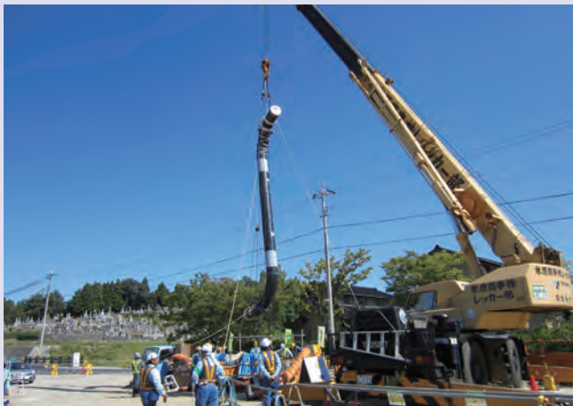
富山ライン建設工事
