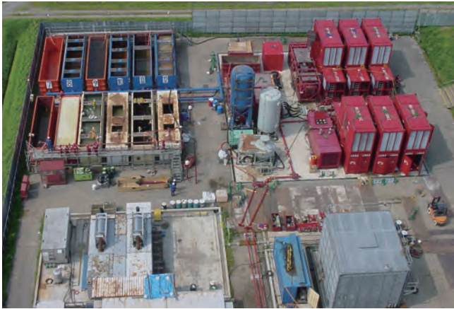
南長岡MHF-1作業現場
