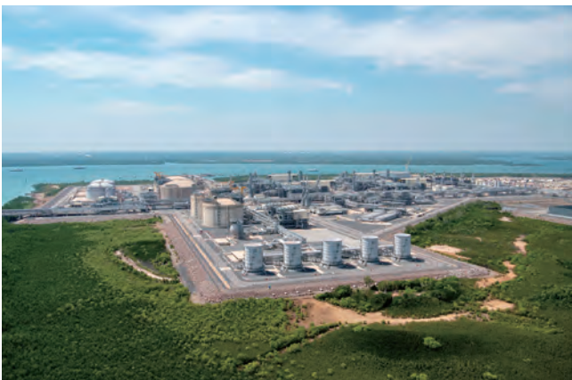
陸上LNGプラント全景
